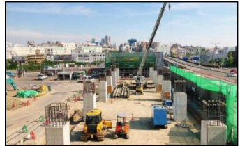
北大阪急行延伸 箕面萱野駅付近
