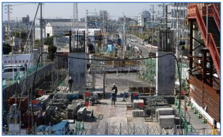
都市計画道路 十三高槻線 (阪急高架部)
