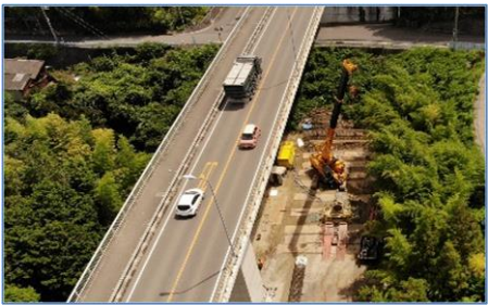
国道170号 (4車線化)
