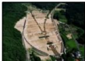
・遊砂地等の整備
