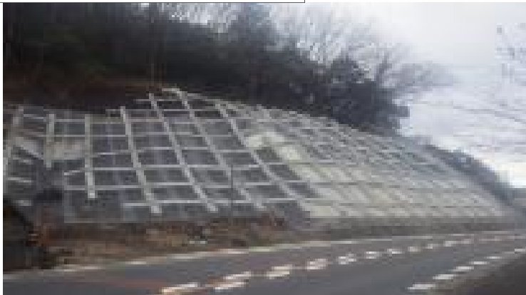
道路のり面对策
