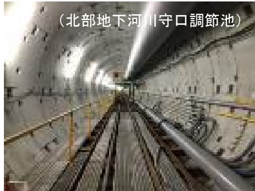
地下河川・流域調節池整備
