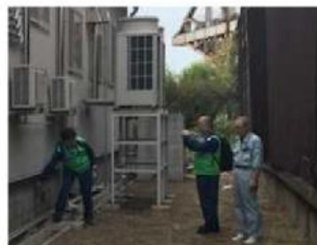
写真3：浸水痕跡調査（堺泉北港湾事務所）
