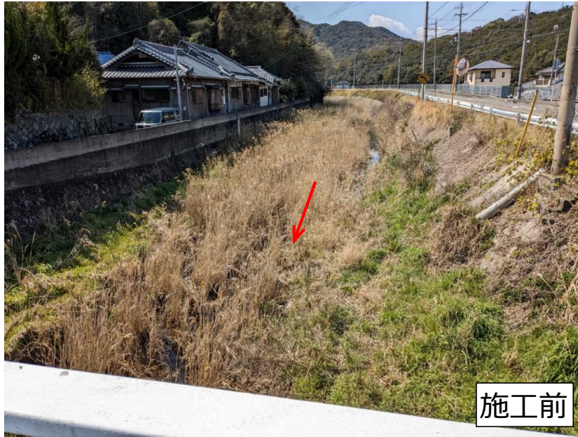
西川堆積土砂除去工事（岬町域）
