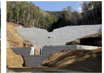
ピーク流量調整機能のある治山ダム（流域治水対策型）の設置
