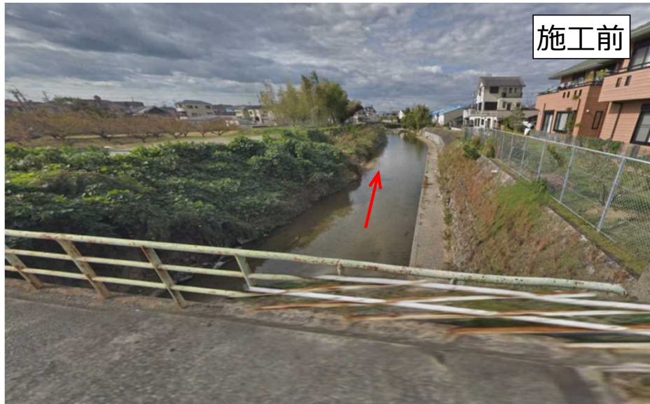
牛滝川河川改修工事（岸和田市域）
