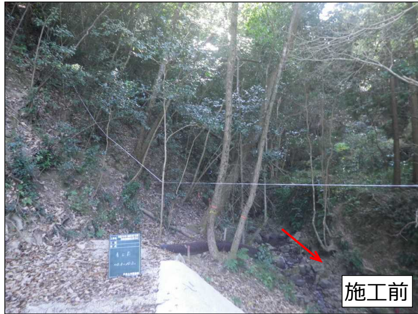
楠畑川第1支溪砂防堰堤工事（泉南市域）
