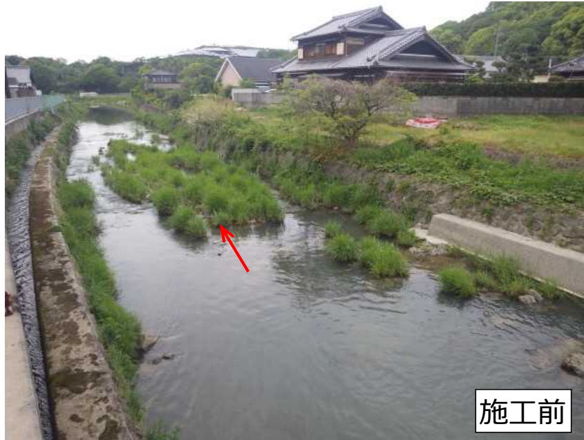
大川河川改修工事（岬町域）
