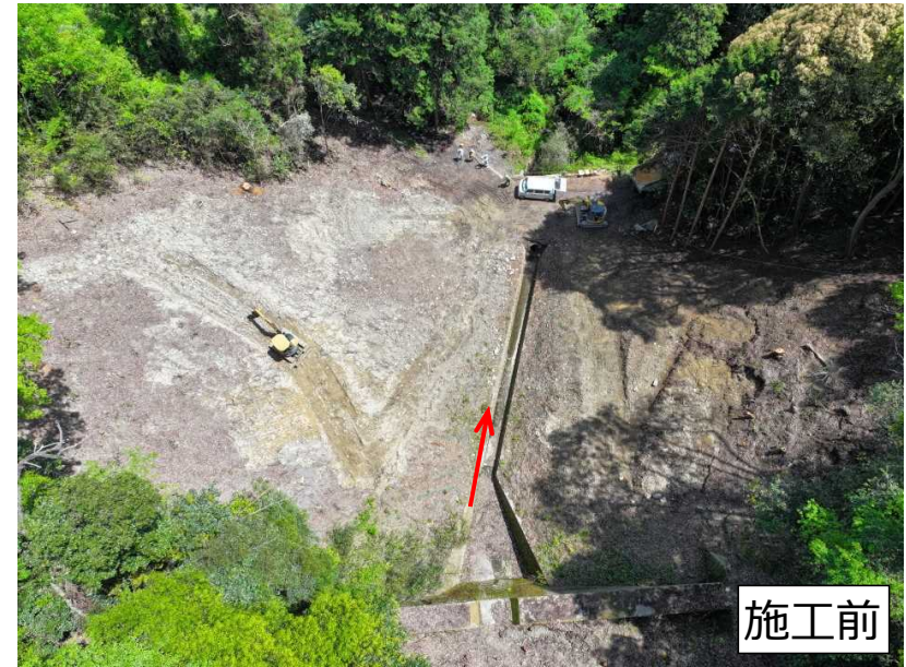
金熊寺川第5支溪砂防堰堤工事（泉南市域）
