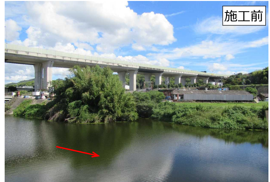
榎井川護岸補修工事（泉佐野市域）
