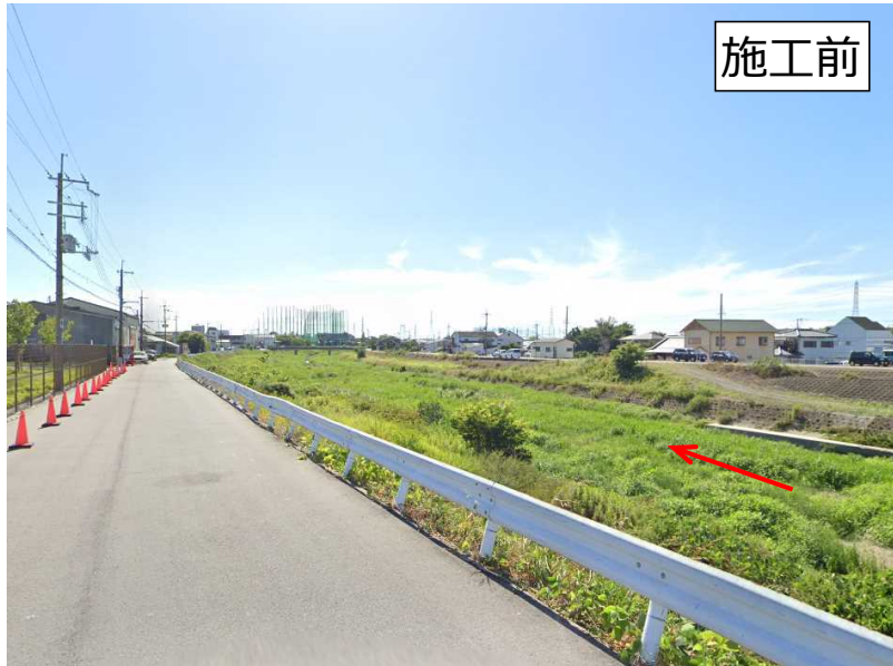
榎井川環境整備工事（泉佐野市域）
