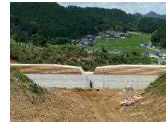
ピーク流量調整機能のある治山ダム（流域治水対策型）の設置
