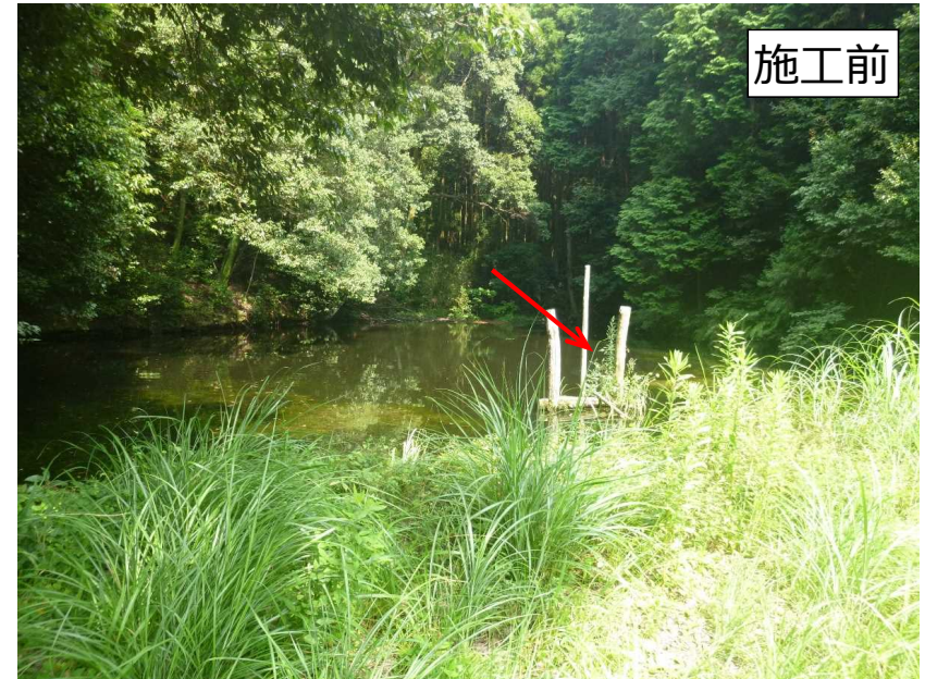
近木川第1支溪砂防堰堤建設工事（貝塚市域）
