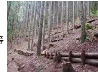
本数調整伐と筋工の施工
