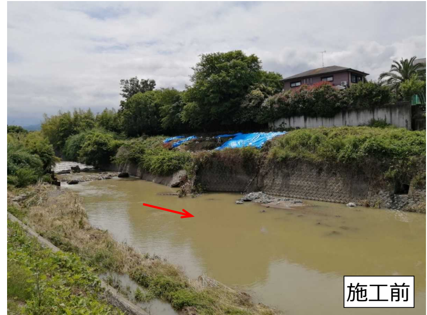
金熊寺川災害復旧工事（泉南市・阪南市域）
