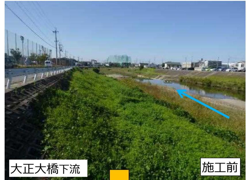
檜井川環境整備工事 (泉佐野市域)
