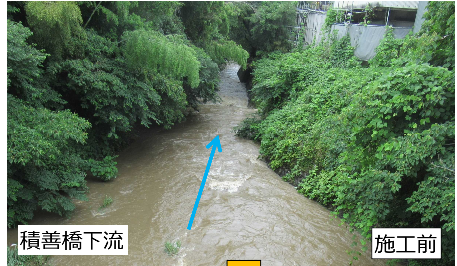
近木川護岸補修 (貝塚市域)
