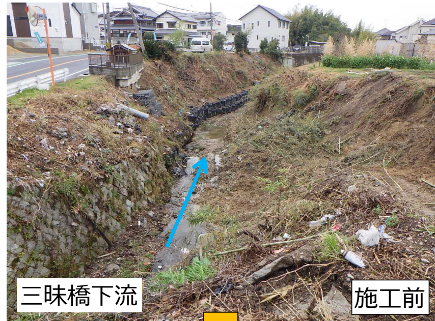
住吉川護岸補修 (熊取町域)
