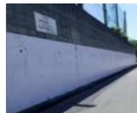
府立学校の改修例 (改修前)
