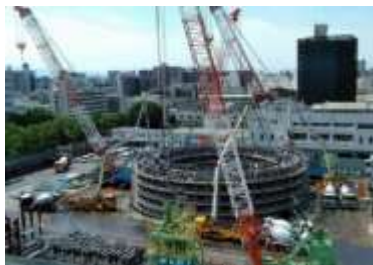
寝屋川北部地下河川(城北立坑) (大阪市)
