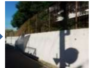
府立学校の改修例 (改修後)
