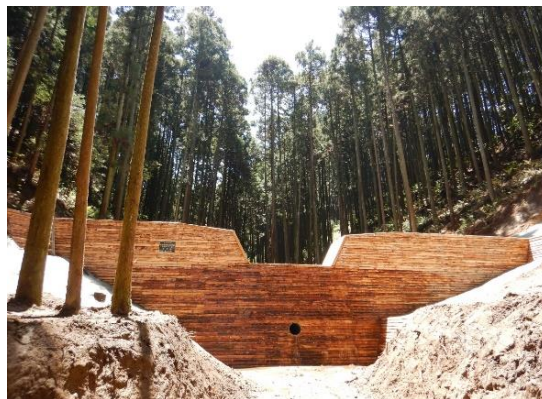
治山ダムの整備
