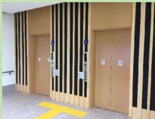
エレベーター
