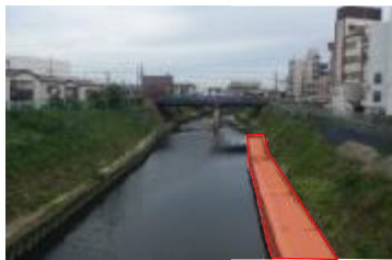
石津川老朽対策 (矢板護岸)
