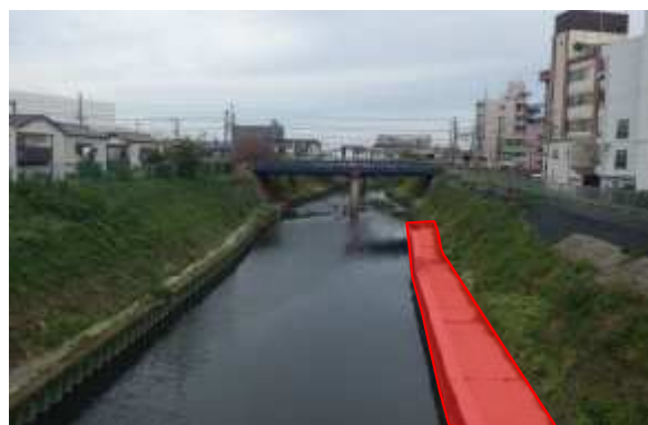
石津川老朽対策 (矢板護岸)
