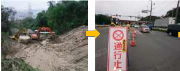
緊急対応業者により崩土等を除去作業を開始 応急対策工事が完了するまでの間の交通規制対応 応急対策工事を完了し片側交通開放
