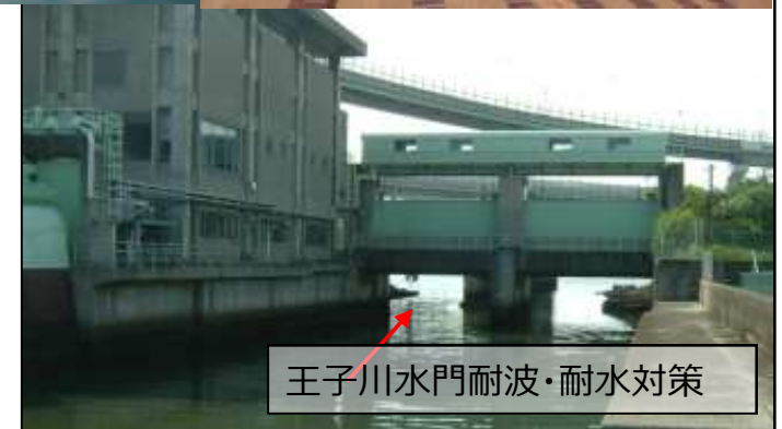
堺旧港の整備
