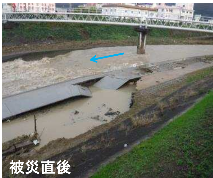
⑯牛滝川 中板橋下流左岸遊歩道（陥没箇所を復旧予定）
