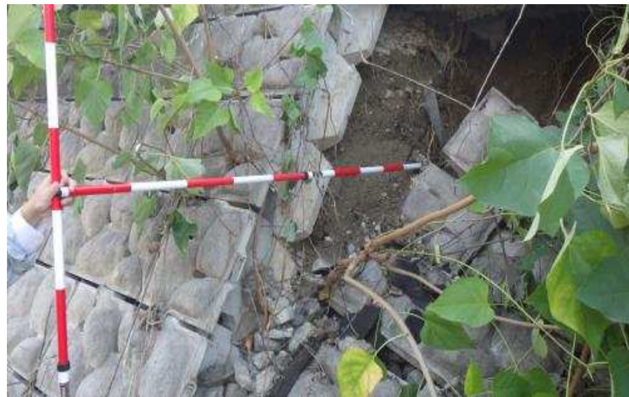
⑯牛滝川 中板橋下流左岸遊歩道（陥没箇所を復旧予定）
