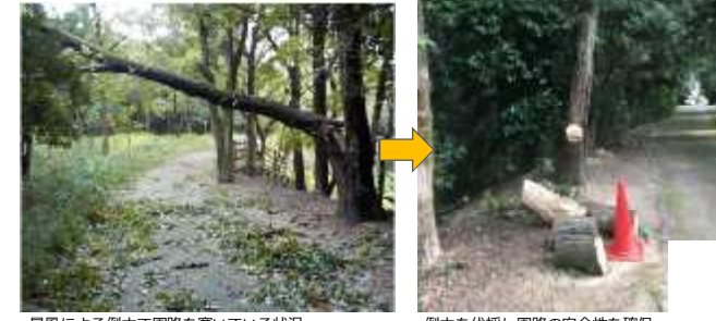
暴風による倒木で園路を塞いでいる状況
