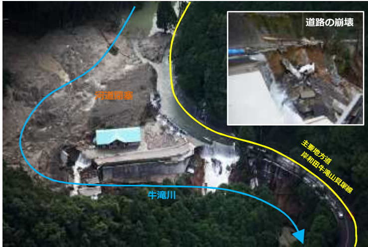
土砂崩落箇所全景（ドローンによる撮影）
