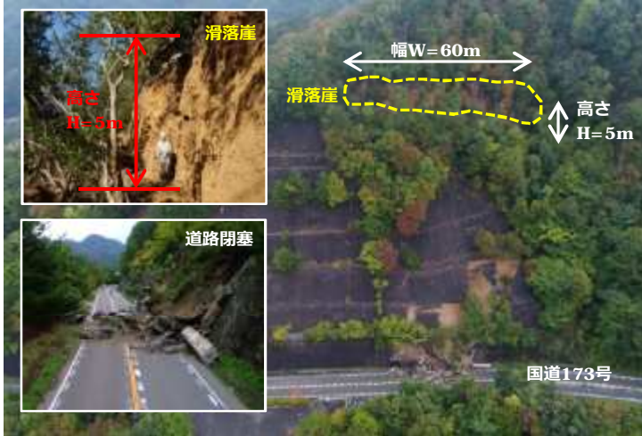
法面崩落箇所全景（ドローンによる撮影）
