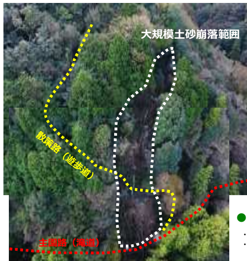
土砂崩壊箇所の全景（ドローンによる撮影）
