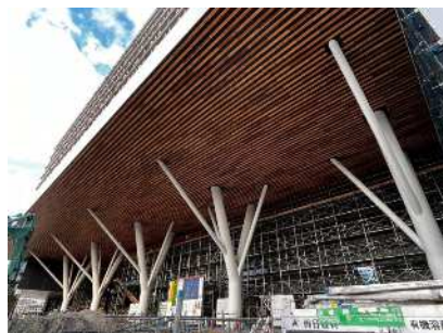
ピロティ軒天井（木質化箇所）
