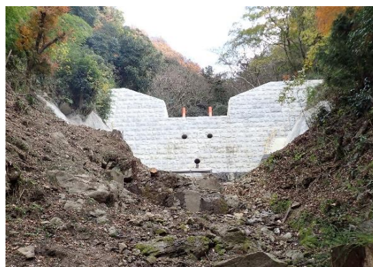
土石流対策事業（一の谷砂防堰堤）
