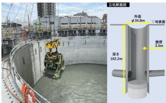
寝屋川北部地下河川【城北立坑】
