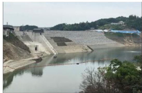
安威川ダム【試験湛水】
