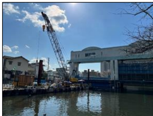
城北寝屋川口水門耐震補強工事
