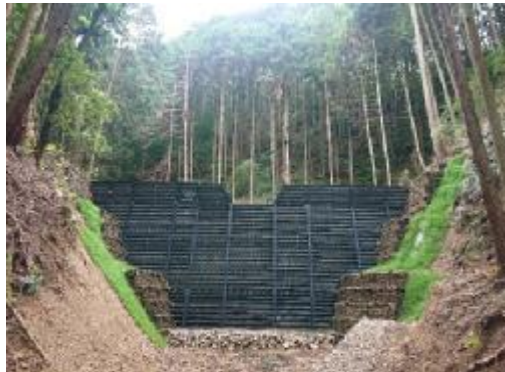
治山ダム（太子町山田地区）【完成】
