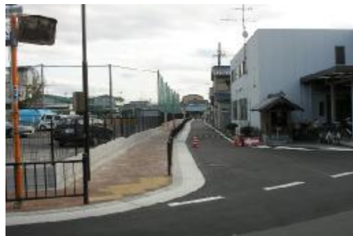
地区公共施設等の整備例（整備後）
