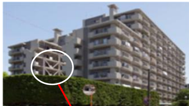
耐震補強箇所（アウトフレーム）
