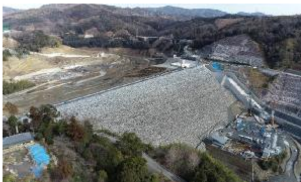
安威川ダム（茨木市）【堤体盛立て完了】
