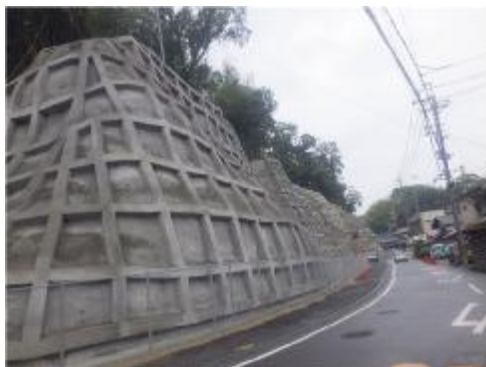
急傾斜崩壊対策事業（河内長野市 谷(2)地区）
