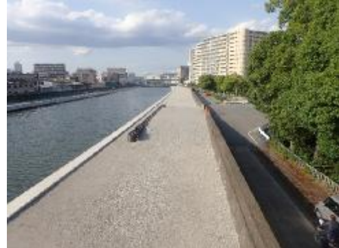
一級河川 六軒家川 防潮堤補強【対策後】
