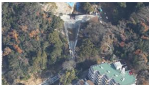
土石流対策事業（東大阪市 鬼虎川砂防えん堤）
