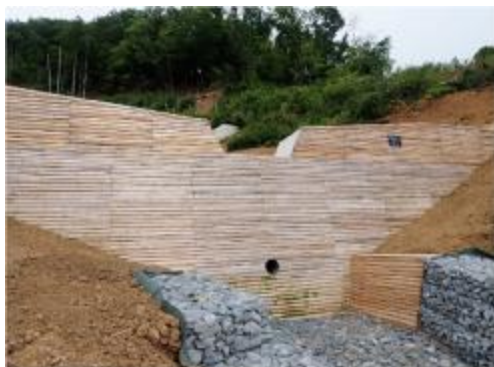
治山ダム（高槻市中畑地区）【完成】
