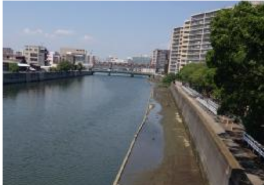
一級河川 六軒家川 防潮堤補強【対策前】
