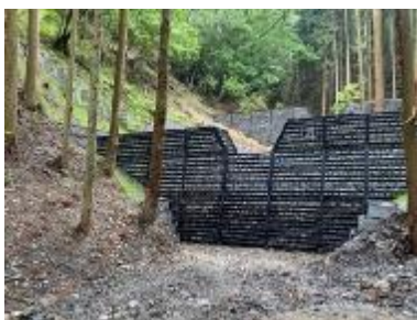
治山ダム（能勢町野間中地区）【完成】
