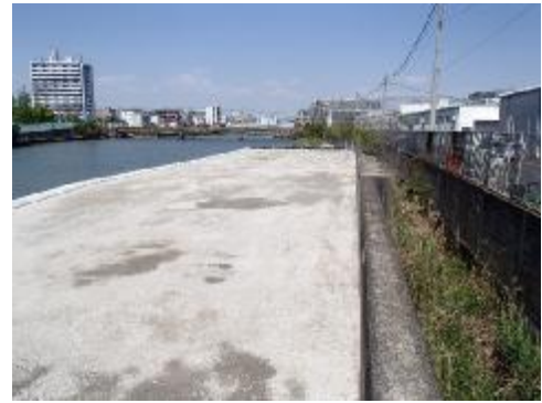
一級河川 六軒家川 防潮堤補強【完成】
