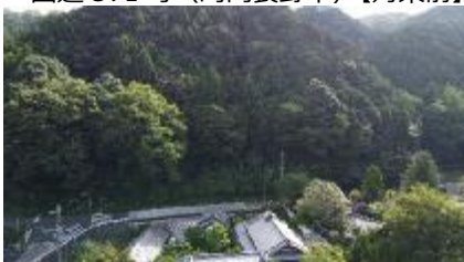
国道 371 号（河内長野市）【対策前】
