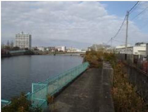
一級河川 六軒家川 防潮堤補強【工事中】
