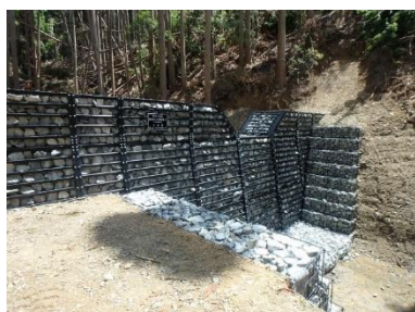
治山ダム（高槻市成合地区）【完成】
