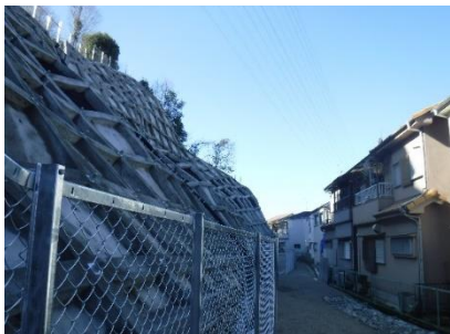
急傾斜崩壊対策事業（河内長野市 喜多町地区）
