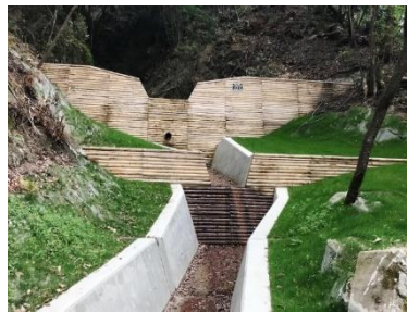
治山ダム（交野市私市北地区）【完成】
