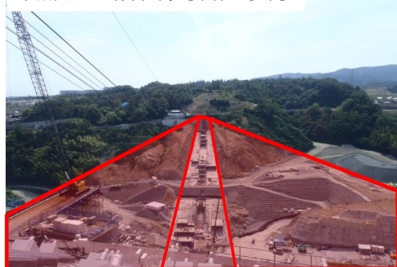
安威川ダム（茨木市）【本体工事中】
