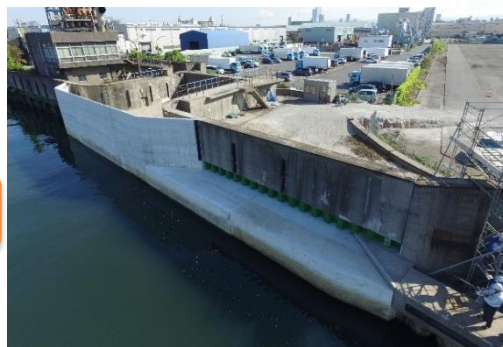
一級河川 木津川 防潮堤補強【完成】
