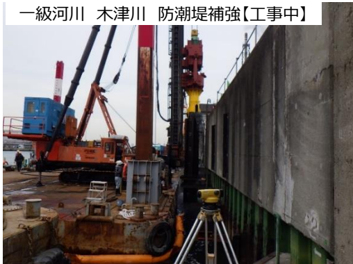
一級河川 木津川 防潮堤補強【工事中】
