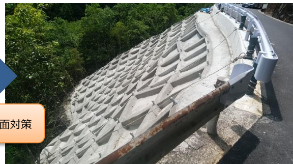
河内長野かつらぎ線（河内長野市）【対策後】
