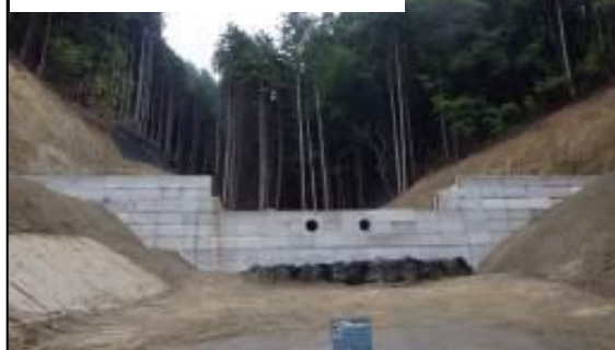
砂防事業（豊能町）【工事中】
