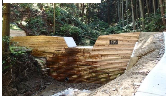
治山ダム（岸和田市）【完成】
