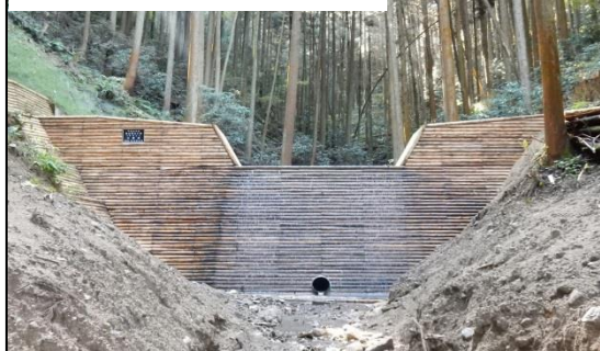
治山ダム（千早赤阪村）【完成】
