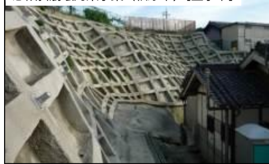
急傾斜崩壊対策事業（柏原市）【工事中】
