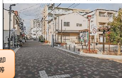
地区公共施設等の整備例（整備後）
