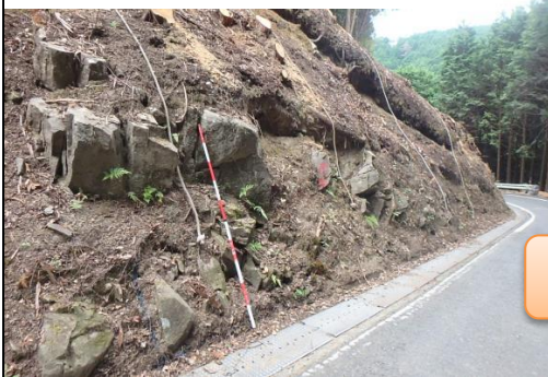
一般国道 480 号（和泉市）【対策前】
