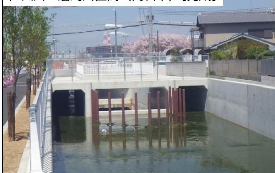
芦田川二層河川区間（高石市）【完成】
