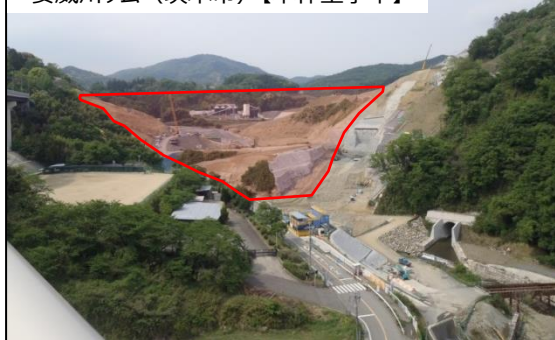
安威川ダム（茨木市）【本体工事中】
