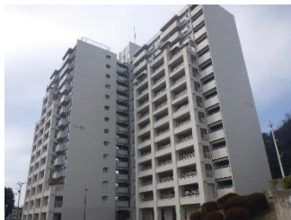
大阪府営桃山台3丁住宅 （堺市）
