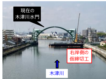
木津川水門工事状況
