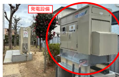
自家発電設備設置（茨木保健所）
