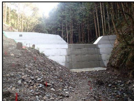
治山ダム（和泉市）
