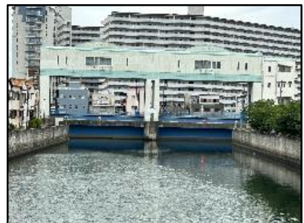
城北寝屋川口水門
