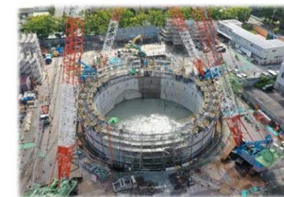
寝屋川北部地下河川・城北立坑 （沈設完了／地下約100m）
