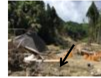
砂防堰堤がなく甚大な被害が発生
