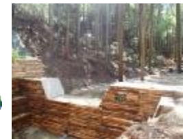
①治山ダム
