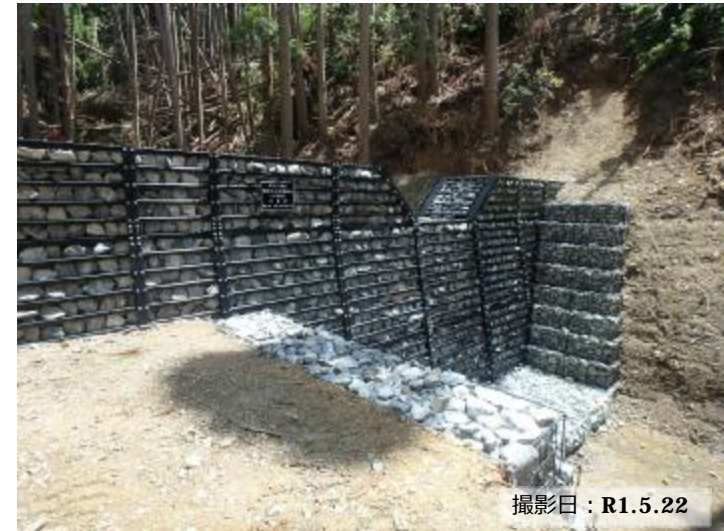
写真① 治山ダム（鋼製）の設置状況
