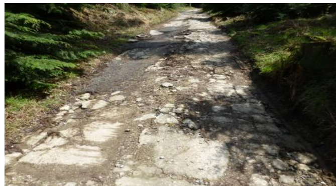
①路面工 (施工前)
