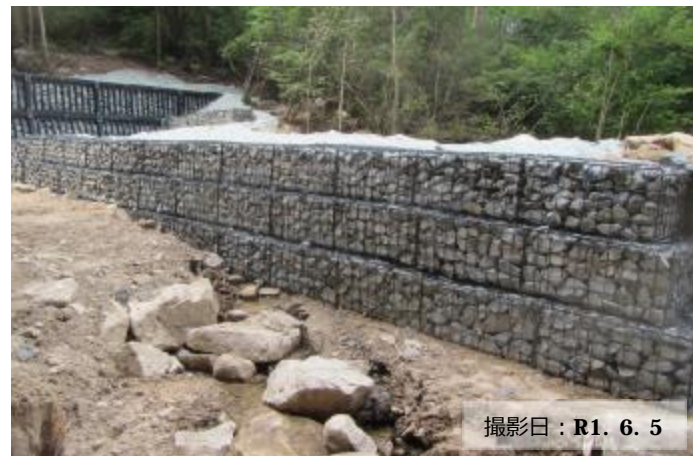
写真② 護岸工の設置状況
