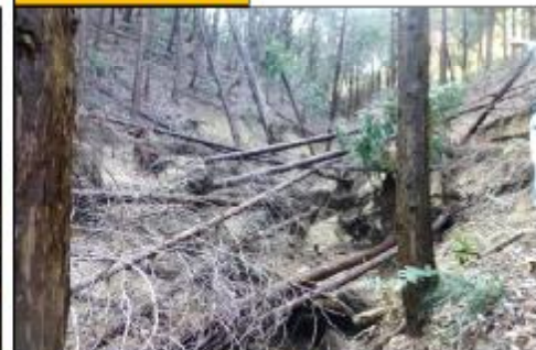
流木となる恐れのある林内の 倒木・危険木の状況(枚方市)
