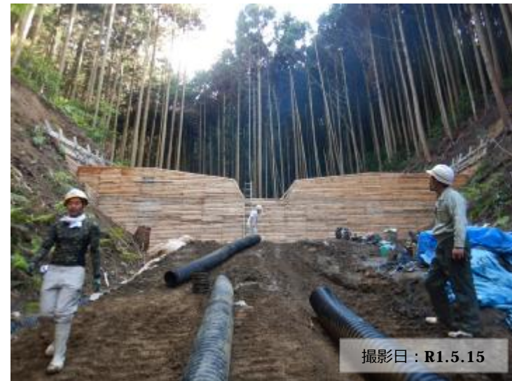
写真① 治山ダム（コンクリート）の施工状況
