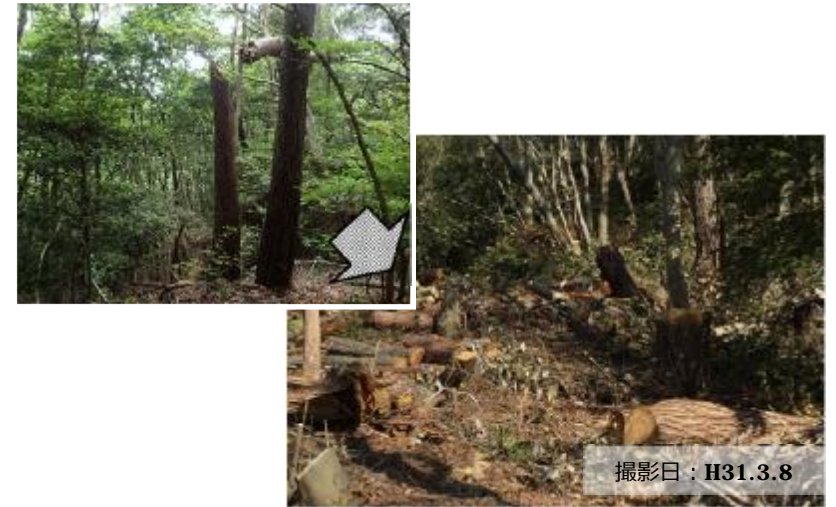
写真① 森林整備（松枯れ・ナラ枯れ被害木整理）の完了状況
