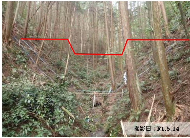
写真① 治山ダム（コンクリート）の設置予定地
