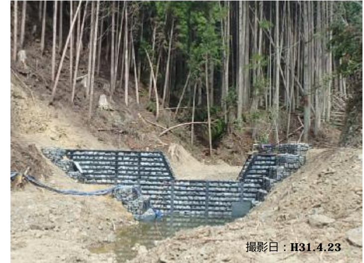
写真① 治山ダム（鋼製）の設置状況
