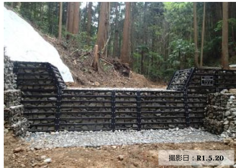
写真① 治山ダム（鋼製）の設置状況
