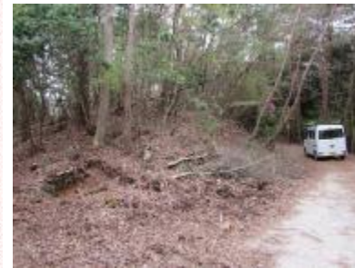
①土場整備工
