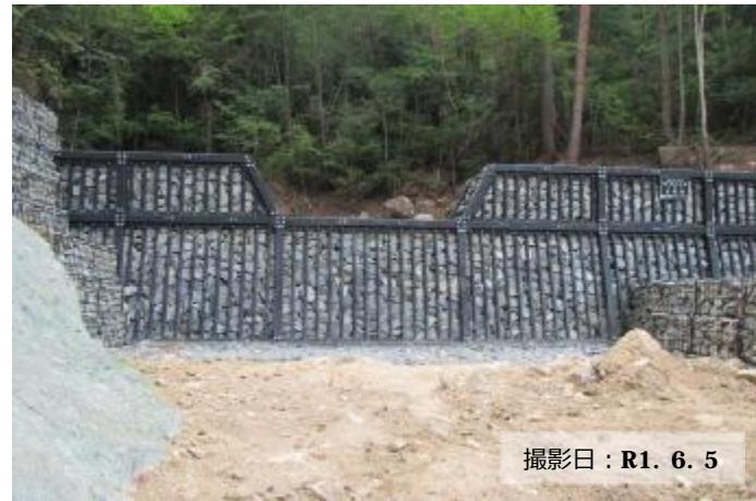
写真① 治山ダム（鋼製）の設置状況
