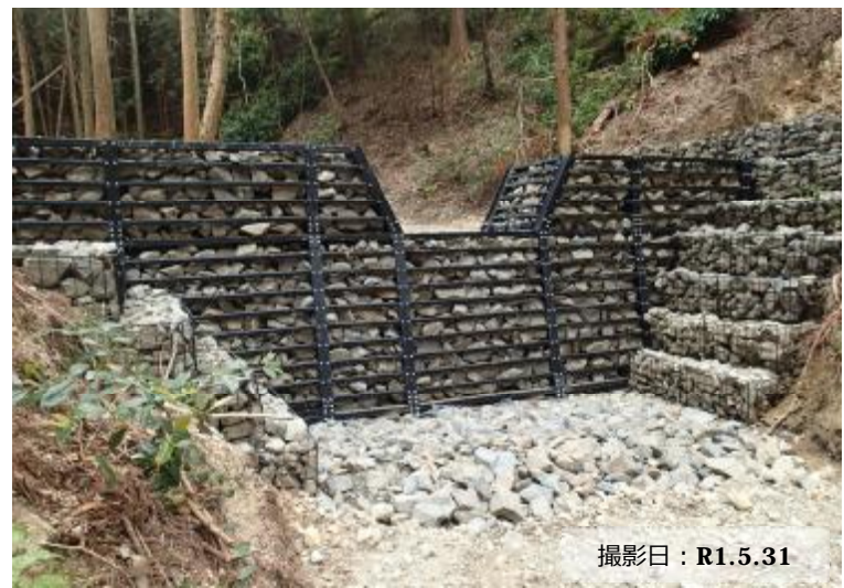
写真① 治山ダム（鋼製）の設置状況
