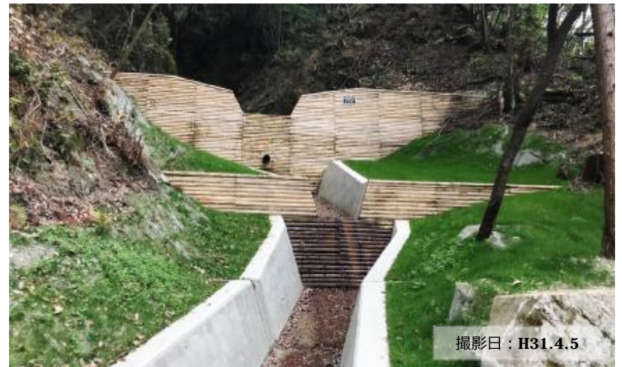
写真② 治山ダム (コンクリート) ・流木対策 施工後
