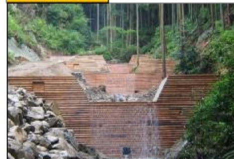
治山ダムの設置により、渓流勾配を 緩和し土石流の発生を未然に防止(千早赤阪村)
