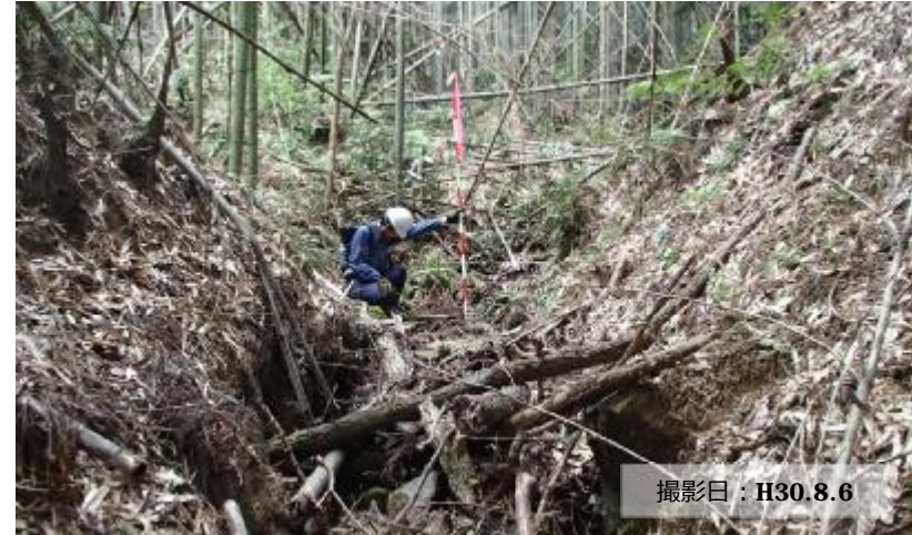
写真① 治山ダム 施工前
