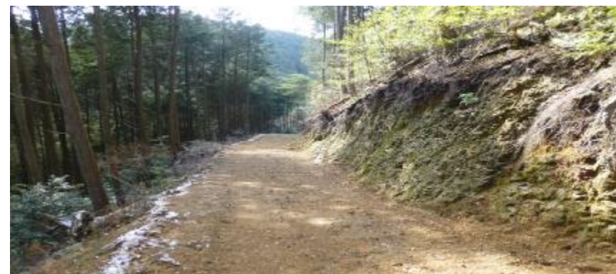
①路面工 (施工前)
