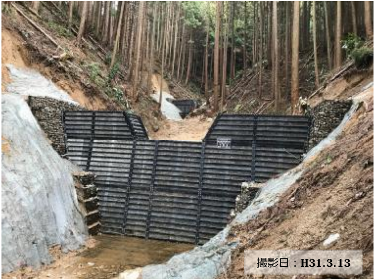
写真① 治山ダム（鋼製）の設置状況
