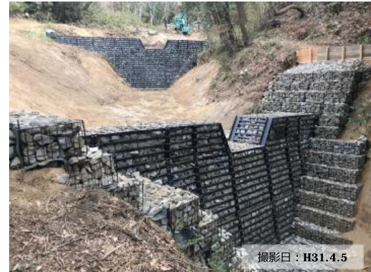
写真② 治山ダム（鋼製） 施工後
