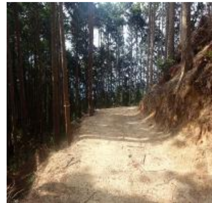
①路面工 (施工前)
