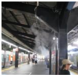
駅のプラットフォーム (駅前広場と一体的に対策)
