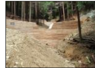
土石流や流木の被害を防ぐ治山ダム
