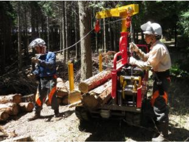
【未利用材回収作業の様子】 R元.7.28
