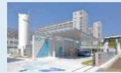
▲充電設備・水素ステーション整備
