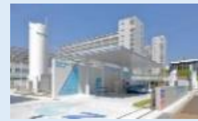
▲充電設備・水素ステーション整備
