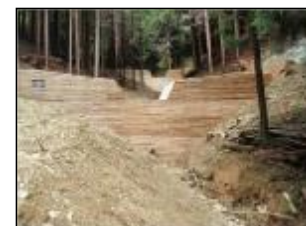
土石流や流木の被害を防ぐ治山ダム
