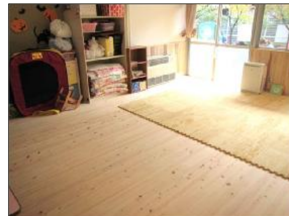
床の木質化（河内長野市・柳風台保育園） H30.10.24 撮影
