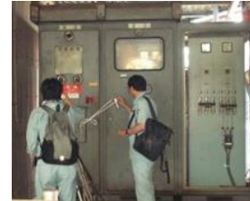
PCB廃棄物に係る立入検査
