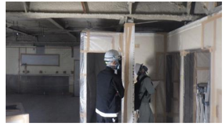
解体現場の立入調査
