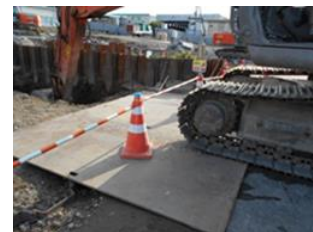
汚染土壌掘削工事の現地確認状況
