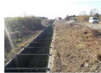
堺第 7-3 区での排水路改修工事
