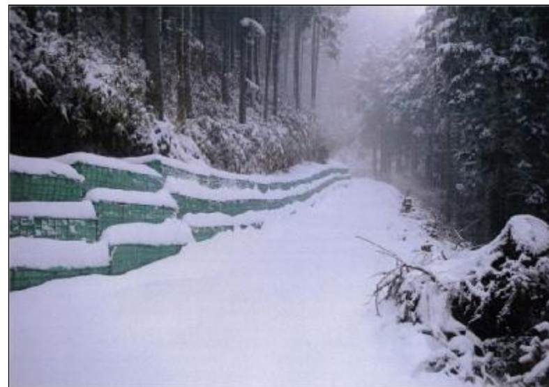
河内長野市セノ谷・島の谷地区 (H29.2.9撮影)
