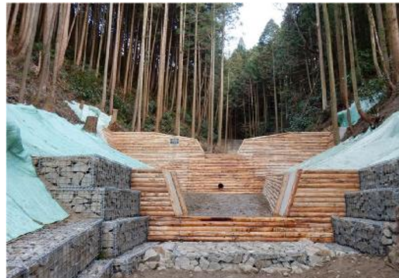
写真① 治山ダム及び流路工（コンクリート）の設置状況
