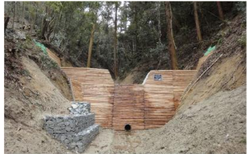
写真② 治山ダム（コンクリート）の設置状況
