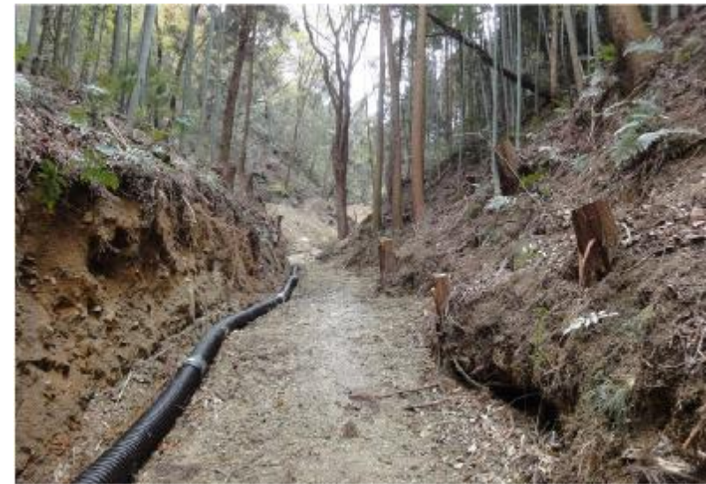
写真② 溪流内の危険木を除去した状況
