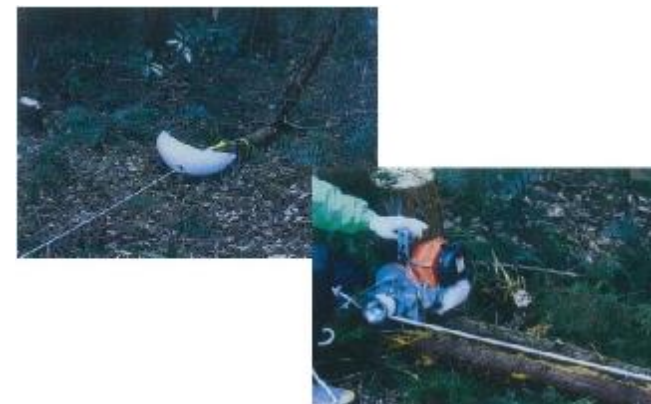
【ポータブル・ウィンチを使用した搬出作業】
