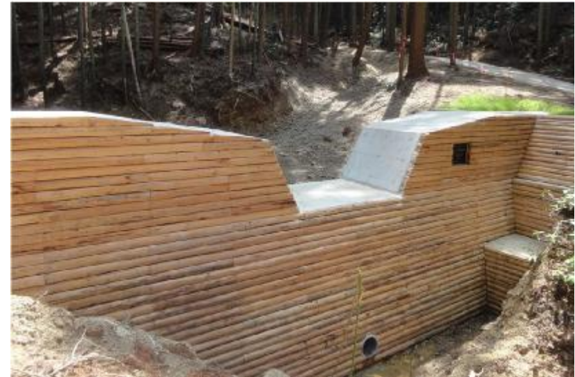
写真① 治山ダム（コンクリート）の設置状況
