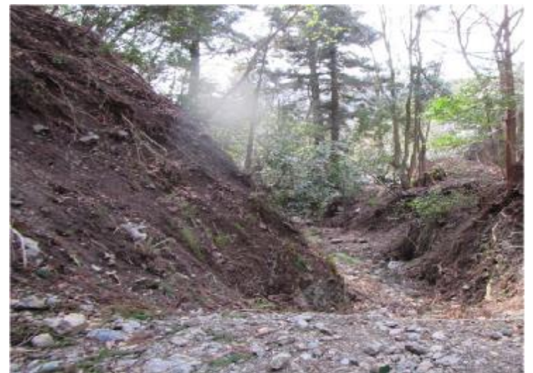
写真② 渓流内の危険木を除去した状況
