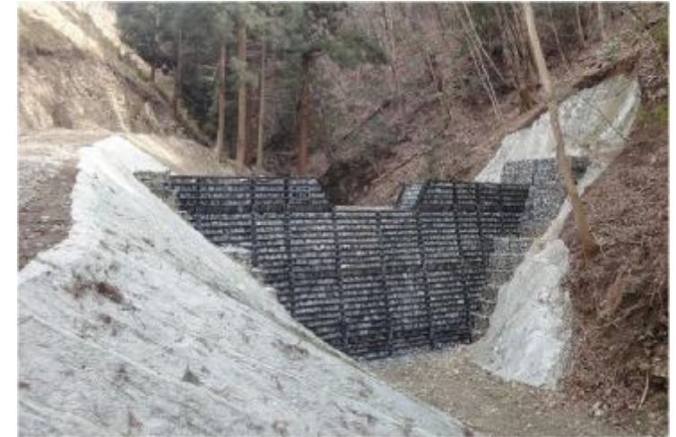
写真① 治山ダム（鋼製）の設置状況
