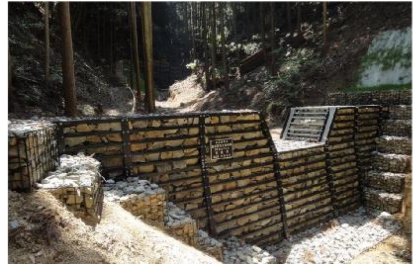
写真① 治山ダム（鋼製）の設置状況
