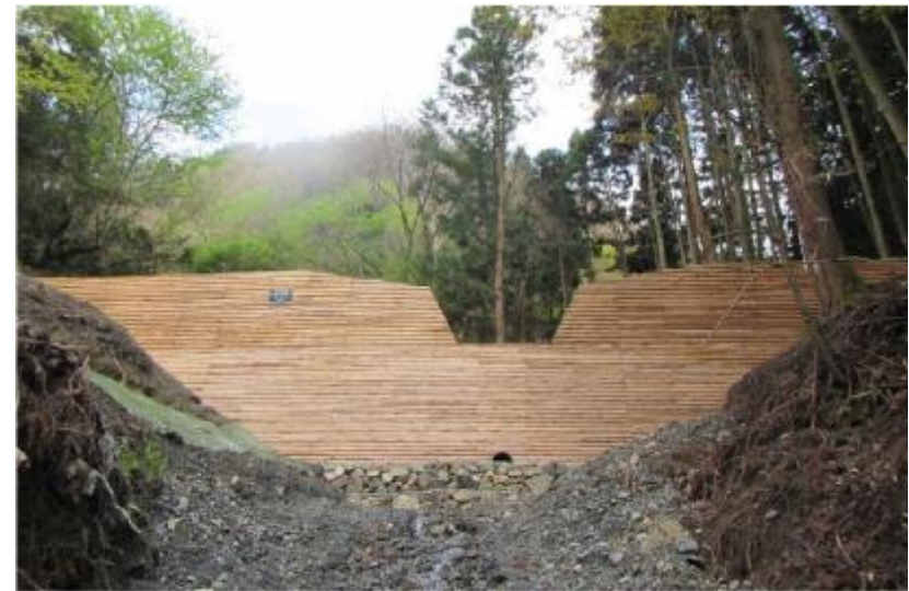
写真① 治山ダム（コンクリート）の設置状況
