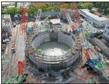
城北立坑（沈設完了／地下約100m）
