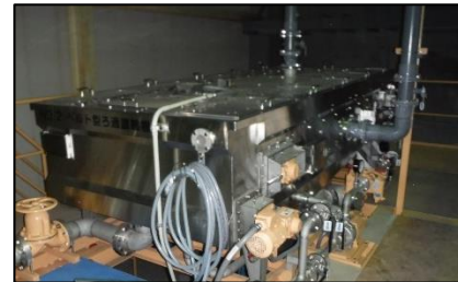
省エネ機器の導入 ベルト型ろ過濃縮機 （高槻水みらいセンター）
