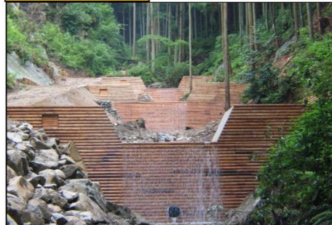
治山ダムの設置により、渓流勾配を緩和し土石流の発生を未然に防止
