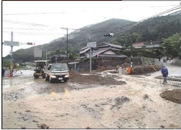
水路閉塞による国道通行止 H26年8月（箕面市）
