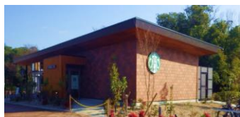
収益施設の設置
