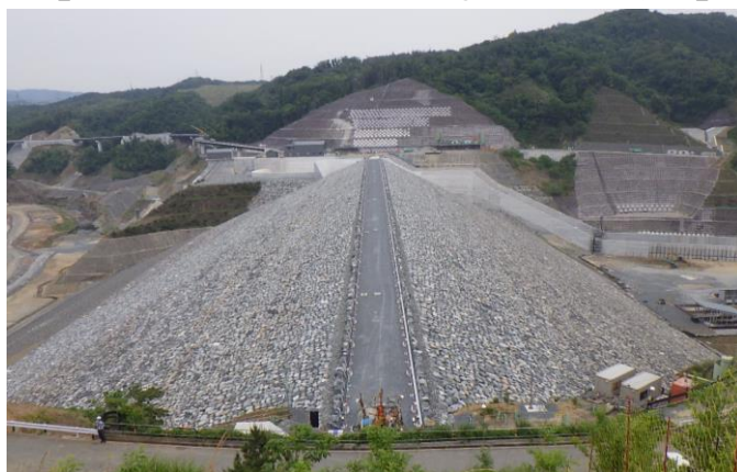
令和4年1月、堤体工が完了。R4年度、試験湛水を開始する。
