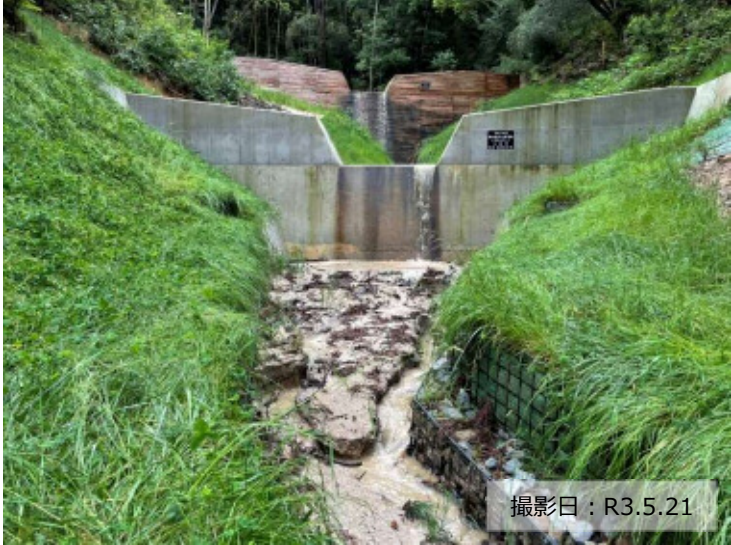
写真① 治山ダム（コンクリート）設置状況
