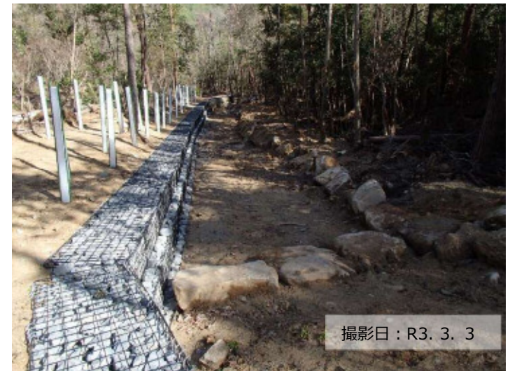
写真② 護岸工の完了状況
