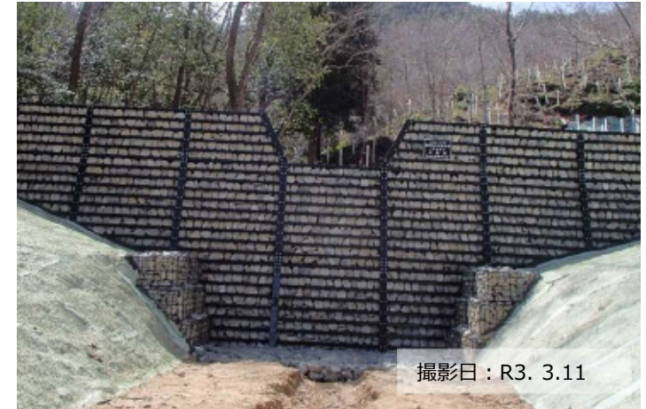
写真① 治山ダム（鋼製）の設置状況
