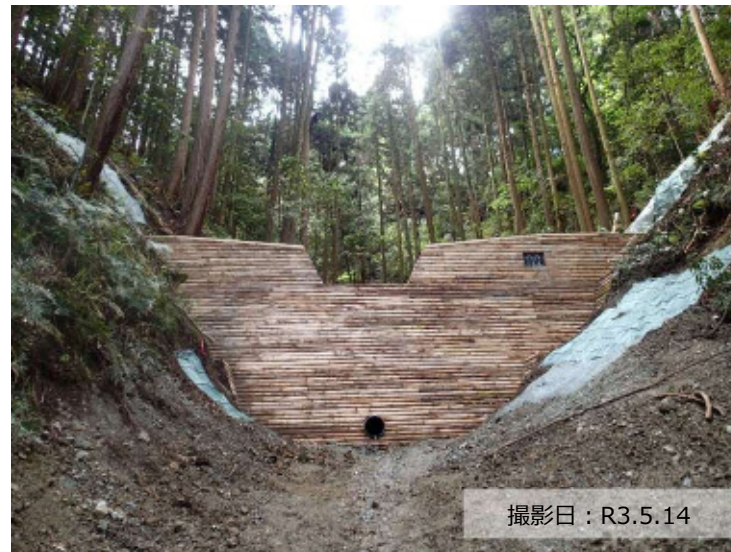
写真① 治山ダム（コンクリート）の完了状況
