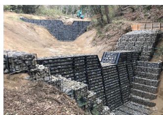
大東市寺川地区 (H30年度竣工)
