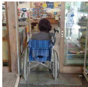
売店出入口幅82cm(引き戸)扉下枠部を丸鋸にて段差解消
