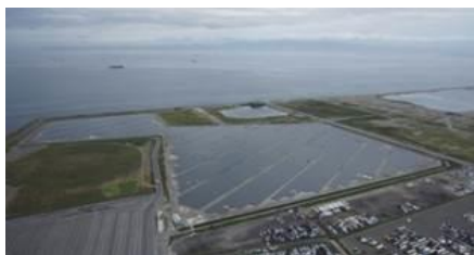
泉大津大規模太陽光発電施設
