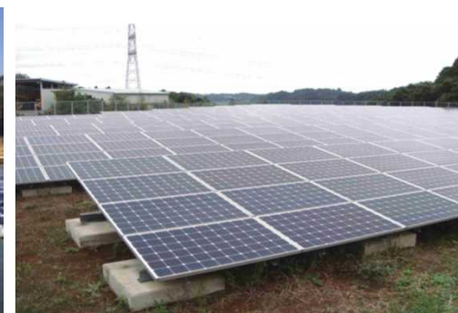
廃棄物処分場
