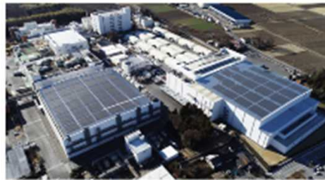
図) 栃木工場の太陽光発電設備(工場内の屋上の様子)
