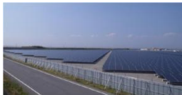
泉大津大規模太陽光発電施設 (泉大津市)
