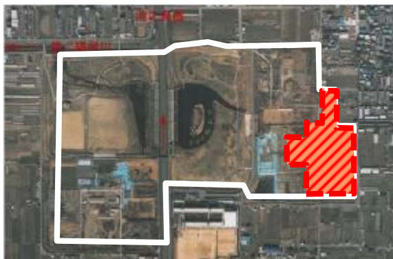
恩智川治水緑地 池島Ⅱ期地区 (東大阪市)
