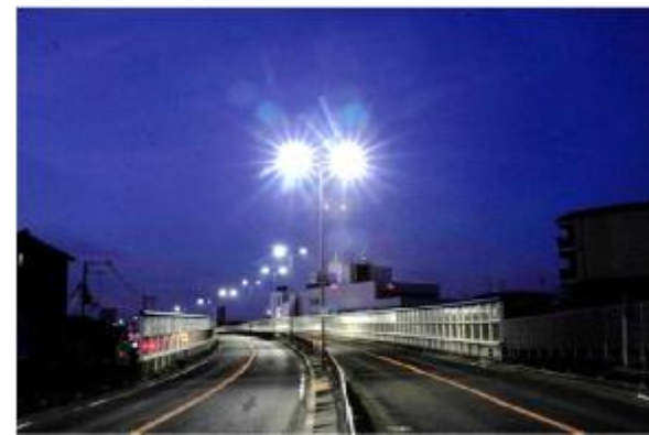
国道170号（羽曳野市内）
