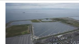
泉大津大規模太陽光発電施設
