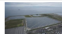
泉大津大規模太陽光発電施設
