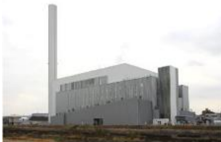
大阪広域環境施設組合 東淀工場
