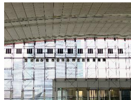
咲洲庁舎に設置されたペロブスカイト太陽電池
