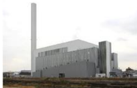
大阪広域環境施設組合 東淀工場
