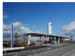
イワタニ水素ステーション 関西国際空港
