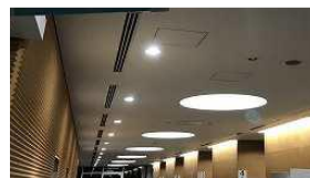
区役所フロアのLED照明
