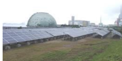
咲洲メガソーラー (大阪ひかりの泉プロジェクト)
