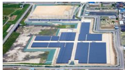
恩智川治水緑地 池島Ⅱ期地区
