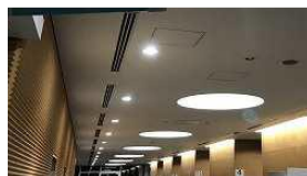
区役所フロアのLED照明
