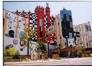
実証フィールド： 大阪広域環境施設組合舞洲工場
