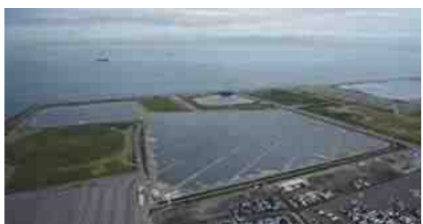
泉大津大規模太陽光発電施設
