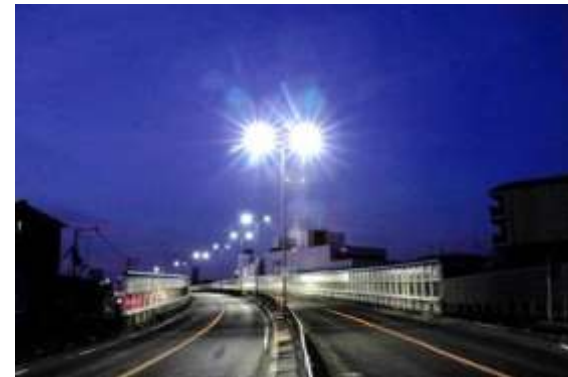
国道170号（羽曳野市内）
