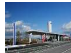
水素ステーション
