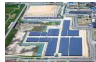
恩智川治水緑地 池島Ⅱ期地区
