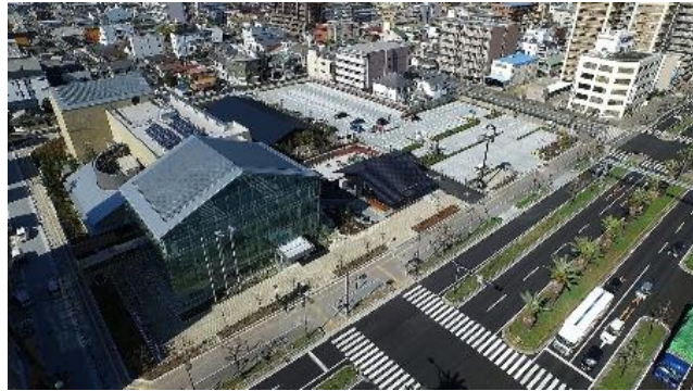
【写真①】施設外観
