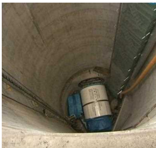
北島立坑(内径14.5m、深さ39.4m—上部写真)から讃良立坑までを掘削するシールドマシンが発進します。
