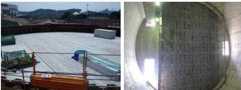
讃良立坑の上面は公園として整備されるため、鉄筋コンクリート製の頂版によって蓋をしています。
