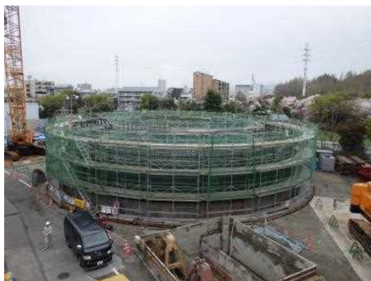
守口立坑の工事中的の様子です。
