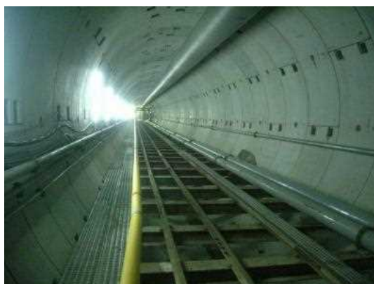
北島立坑から讃良立坑の区間の工事の様子です。
