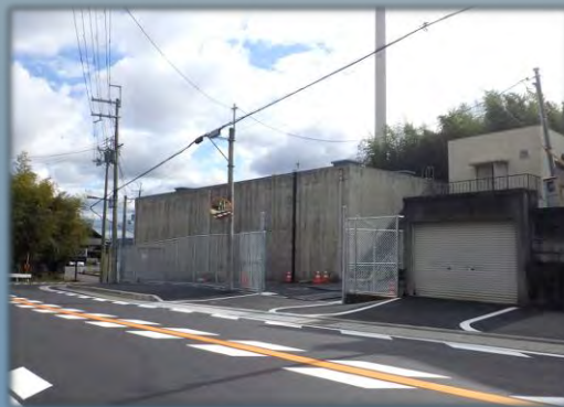
上原減圧水槽 (約184m)
