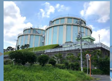
金剛東配水池 (約146m)
